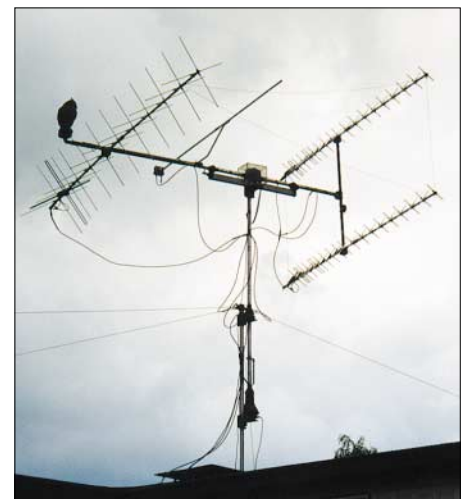
Bild 2: Zu den Messungen benutzte Antennenanlage von DJ1YQ
